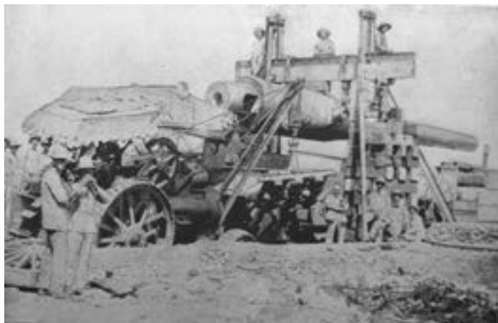
Trabajos de construcción batería No. 2. Montaje de un cañón Krupp de 30.5 cm.
