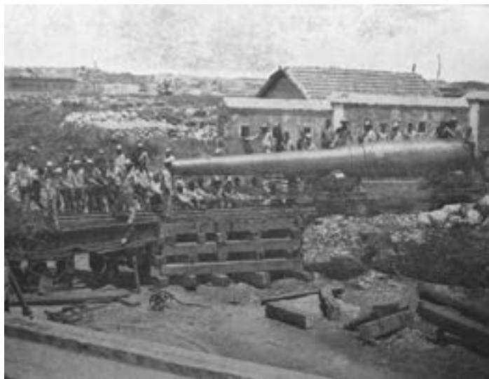
Batería de Santa Clara. Montaje de un cañón Ordóñez de 30.5 cm.
