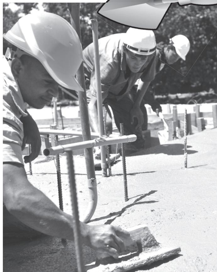
Mantener la altura y horizontalidad de la balsa de cimentación asegura la nivelación de la obra.
