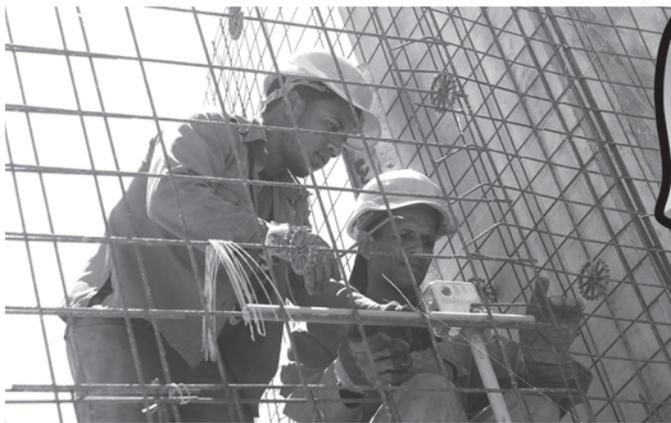
Fijar los conductos para las instalaciones hidrosanitarias, eléctricas y telefónicas antes del hormigonado de los muros, es una tarea de suma importancia.
