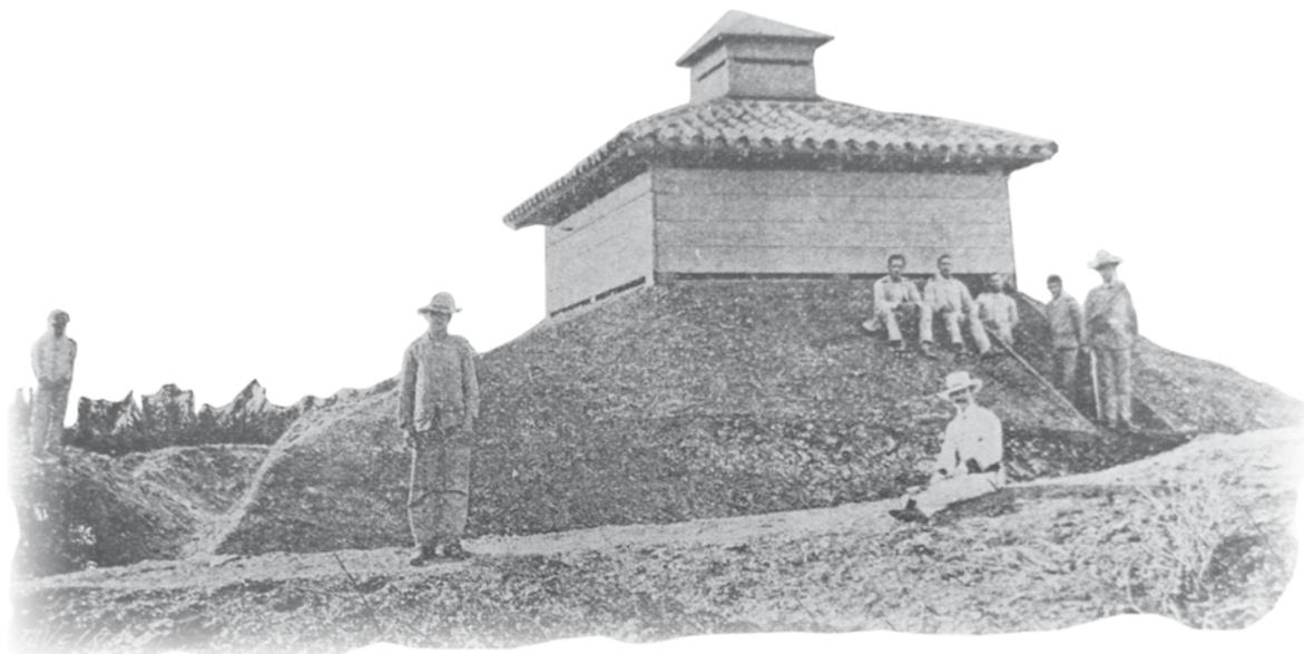
De madera, situado al final de la calle Martha Abreu, en Santa Clara. Revestido por un parapeto de tierra hasta la altura de las aspilleras (1896).
