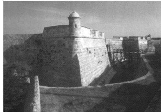
Frente terrestre. En primer plano, baluarte con garita. Al centro, puente levadizo.
