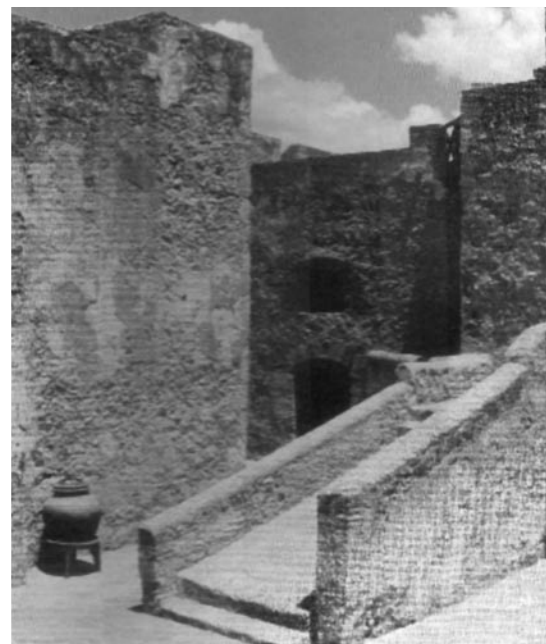
Patio interior del castillo.
