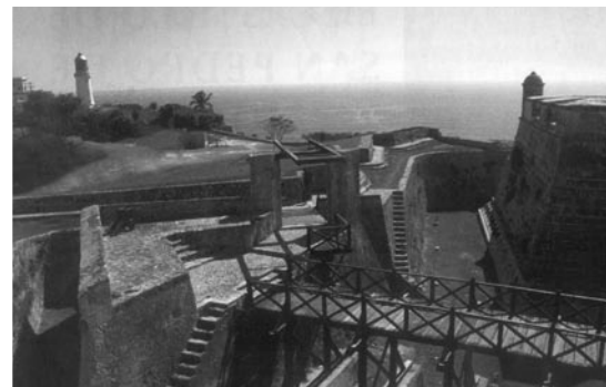
Frente terrestre. En primer plano, revellín (obra de avanzada) con puente fijo de acceso al exterior.
