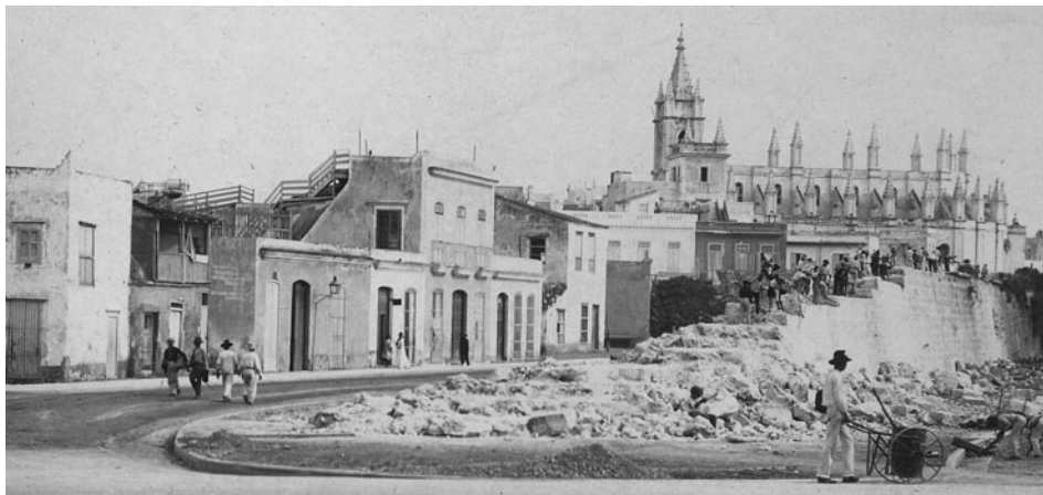
Trabajos de demolición de la muralla.
