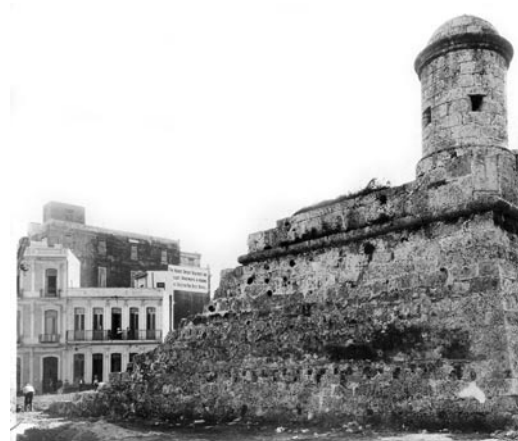
Muralla terrestre. Garita del Baluarte del Ángel.
