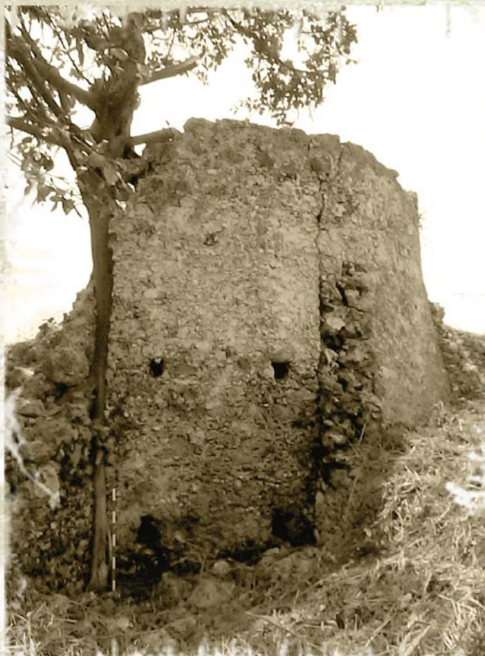
Campo Atrincherado: tramo de camino cubierto. Foto actual.
