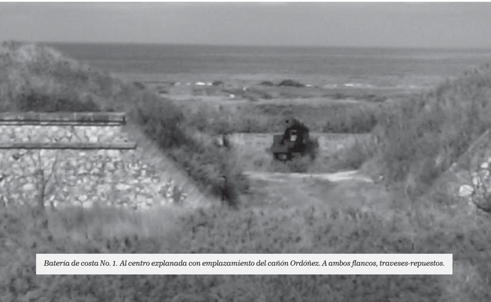
*Batería de costa No. 1. Al centro explanada con emplazamiento del cañón Ordóñez. A ambos flancos, traveses-repuestos.*
