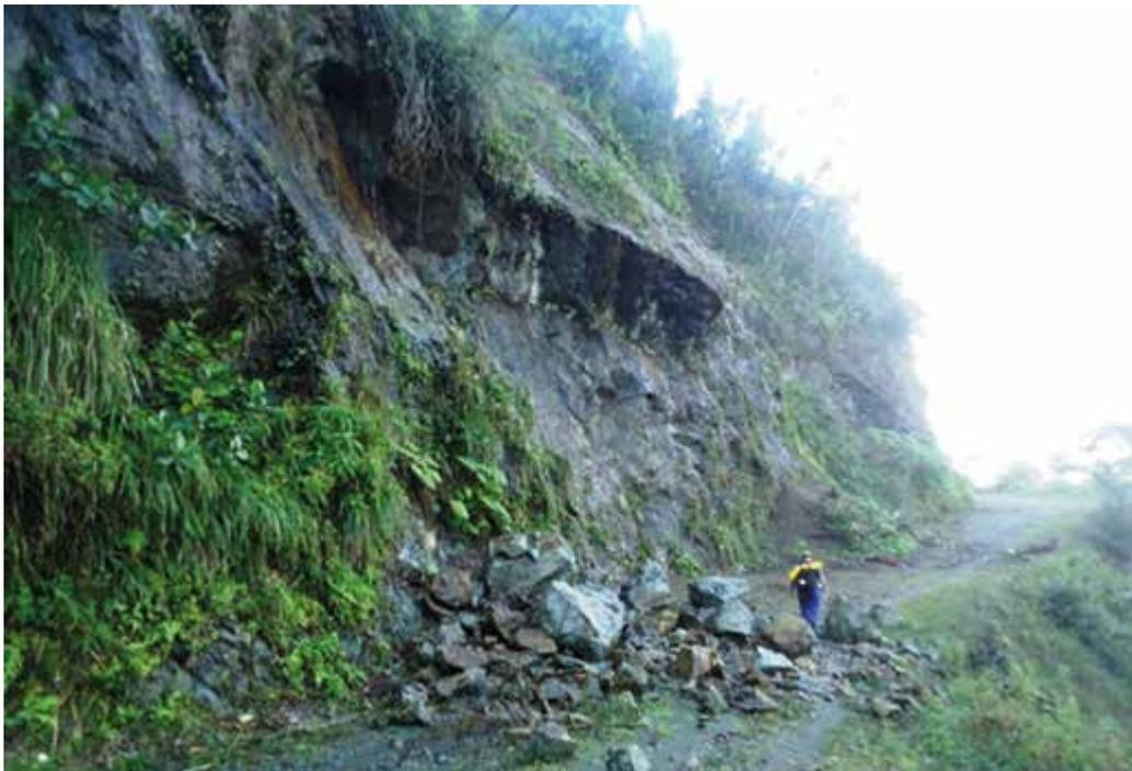
Vía Mulata, Guantánamo. Evidencias de antiguo deslizamiento de traslación reactivado con elementos de caída de rocas. Factor disparador: lluvias intensas. Foto: **Pérez-Aragón**
