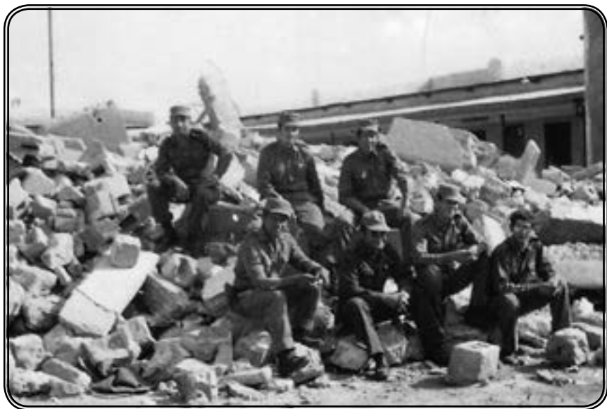
Miembros del puesto de mando avanzado, sobre las ruinas de una instalación destruida en la región de Harewa.
